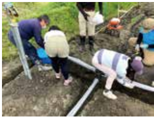
▲土壌の水はけを良くするために畑内に排水を良くするための暗渠（あんきょ）を設置。ホップの苗も畑内に仮植えを行いました。
